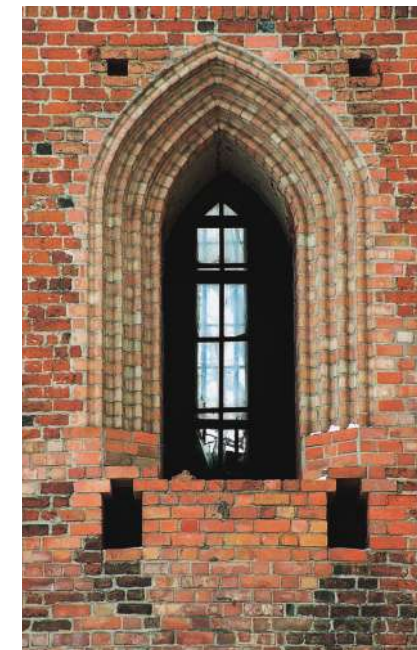
Portal do dawnego refektarza, poniżej gniazda belek, na których opierał się krużganek
