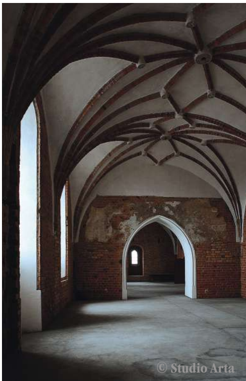
Wnętrze dawnej kaplicy ze zrekonstruowanym sklepieniem gwiaździstym, w głębi dawny refektarz, 2009 r.
