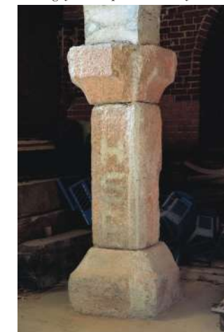
Pomieszczenie przyziemia w części południowej, obok kamienna kolumna dźwigająca sklepienie dawnej kuchni
