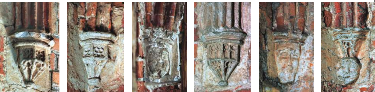
Wsporniki służek sklepiennych z kaplicy i refektarza, 2003 r.
