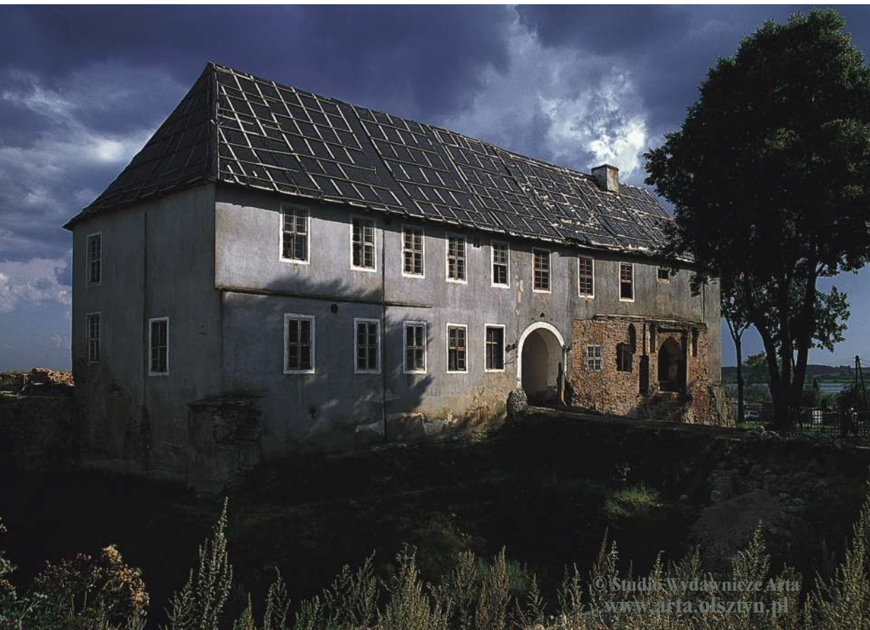
Torflügel mit freigelegtem gotischem Tor, Ansicht von Nordosten, Zustand von 2003
