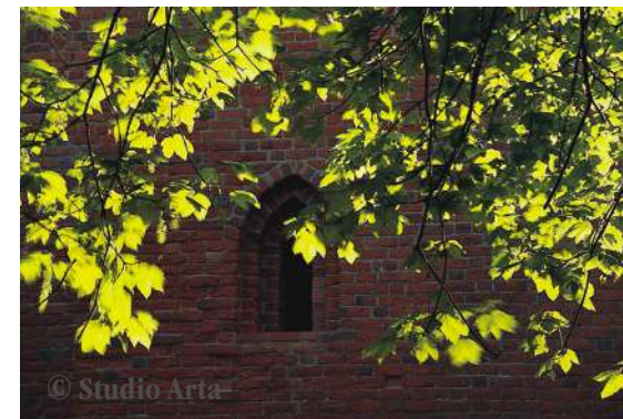
Gotyckie okno w elewacji wschodniej
