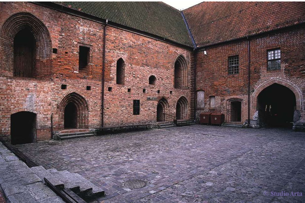
Blick in den Innenhof von der nordöstlichen Ecke aus
